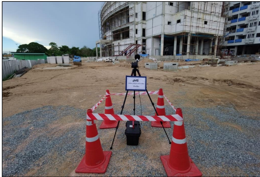
รูปที่ 4.3.2-11 แสดงการตรวจวัดระดับเสียงโดยทั่วไป (ภายในพื้นที่โครงการ)
